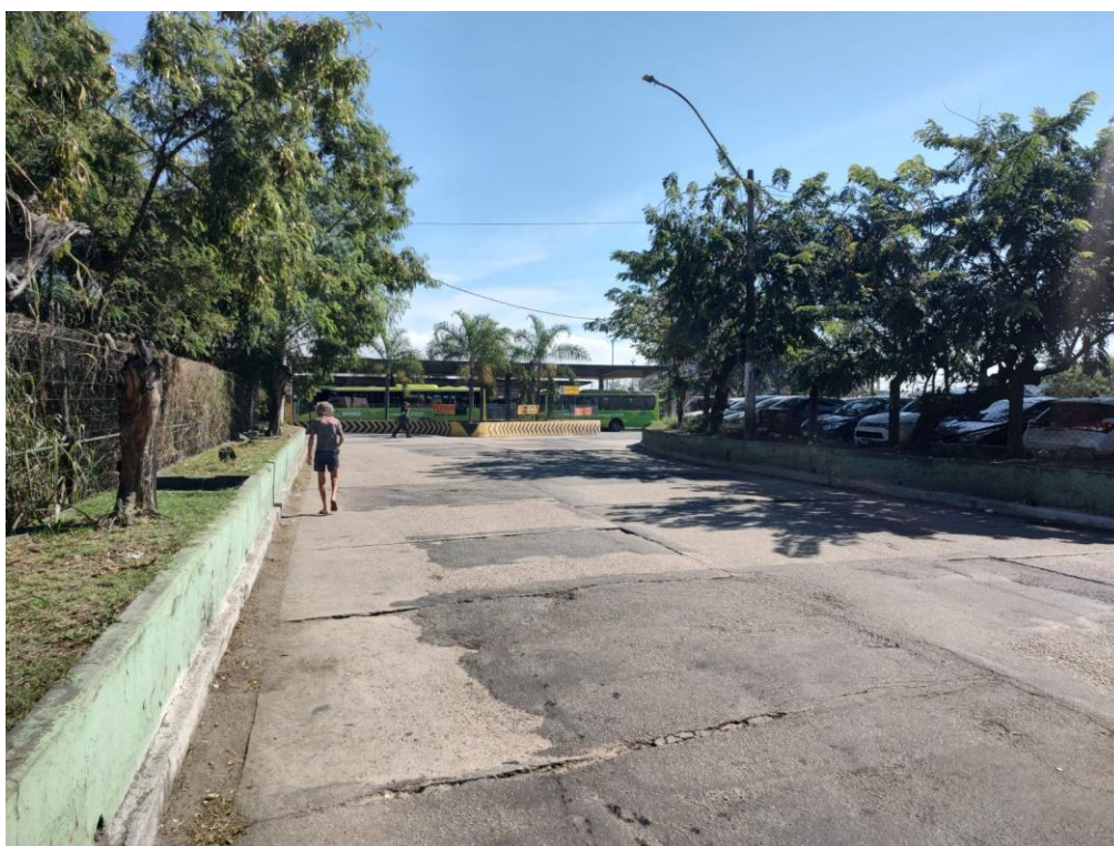
Figura 10 – Lateral esquerda do espaço, acesso para ônibus no terminal.
